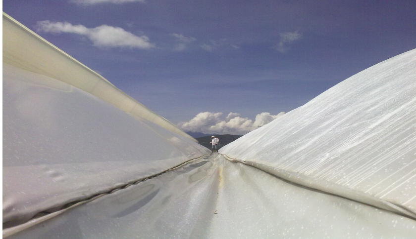
Figura 52. - Pintando capaz del invernadero con pintura vinílica como estrategia para bajar la cantidad de luz que entra al invernadero.
